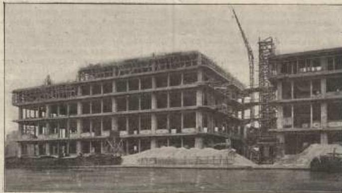
Fig. 19. — Vue des magasins en béton armé en construction
