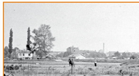
Détail de la photographie de la Fontaine Saint-Lucien, dans les années 1920 (Collection municipale)
